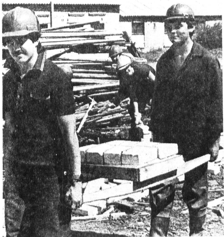
Из фотолетописи ССО-81. Бойцы отряда «Одиссей» на строительных работах в совхозе «Верево».
