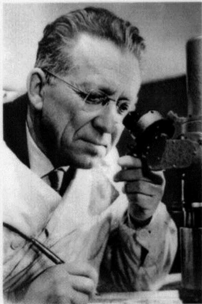
1962 г. Профессор М.М. Русинов за работой: выполняется контроль глубокой асферики
