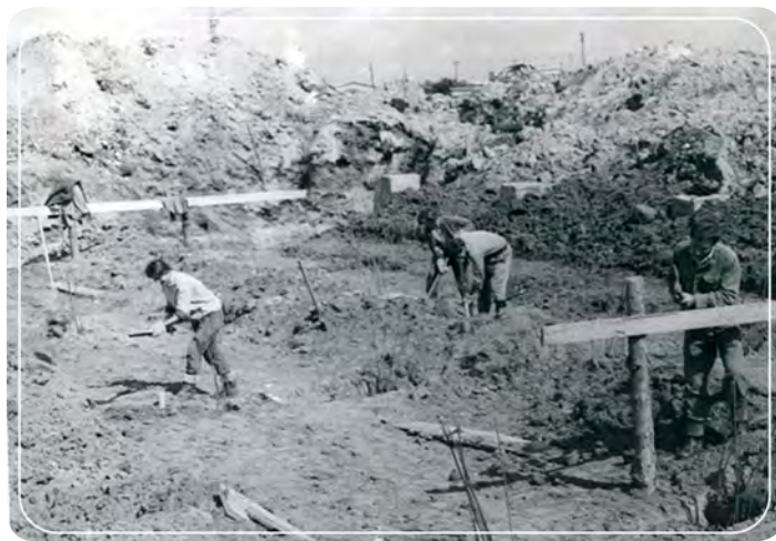
Бойцы отряда ЛИТМО на строительных работах. Гатчинский район
