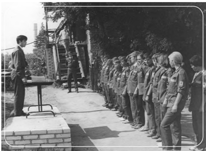
Комиссар Ю. Гатчин перед вручением комсомольских путевок. Главным объектом был 16-квартирный жилой дом, где студенты показали себя с самой лучшей стороны: трудились и штукатурами, и плотниками. Дом был сдан в срок при высоком качестве всех работ
