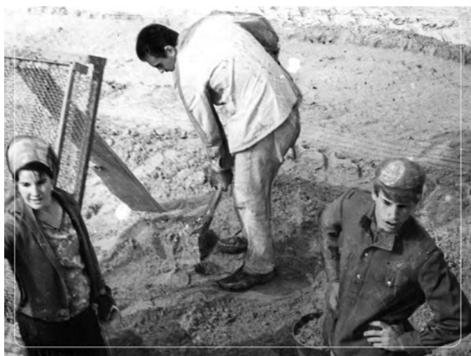
На фотографии: бойцы отряда «Товарищ» на стройке в Ставропольском крае
