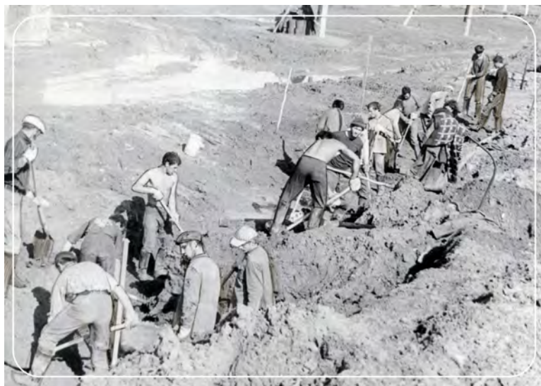
Бойцы ССО «Таёжный» на строительстве теплотрассы
