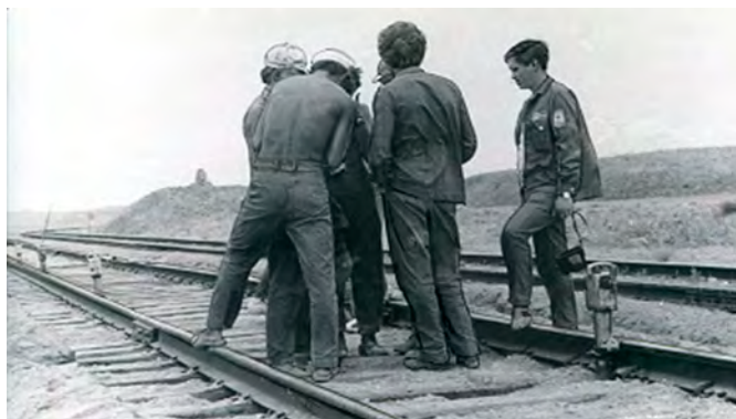
По бескрайним просторам страны на сотни километров протянулись стальные магистрали, в сооружении которых участвовали ССО ЛИТМО. Бойцы ССО «Монолит» на строительстве железнодорожной магистрали в Казахстане. Зональный отряд «Балхаи»
