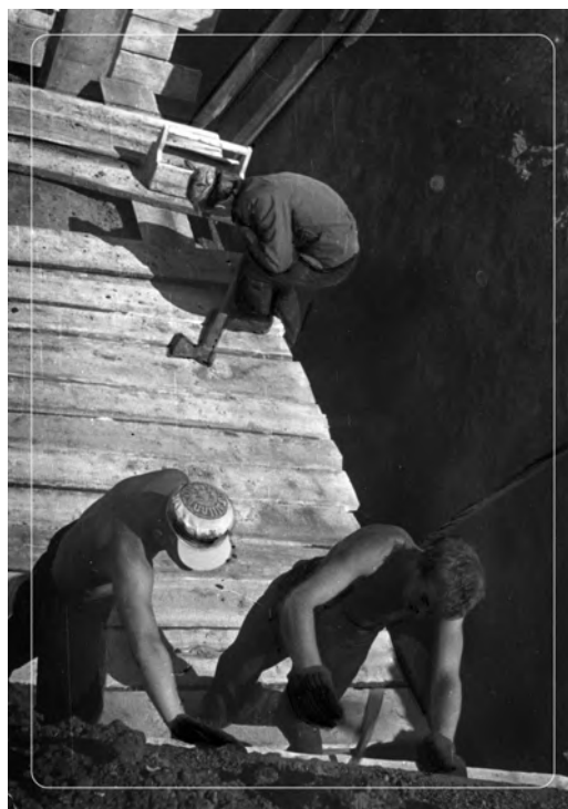
На строительстве Камского автомобильного завода. Бригада литмонавтов на сооружении пожарного водоема
