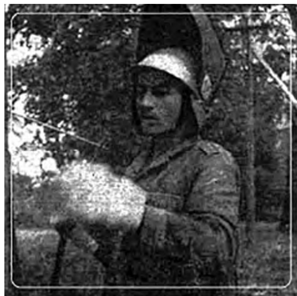
Командир ССО «Неподдающиеся» Юрий Токарев на строительстве молочно- приемного пункта – одном из объектов, где трудился отряд
