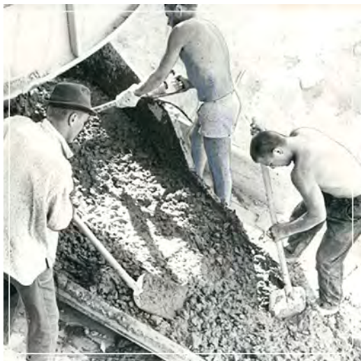
Отряд «Восток» на бетонных работах
