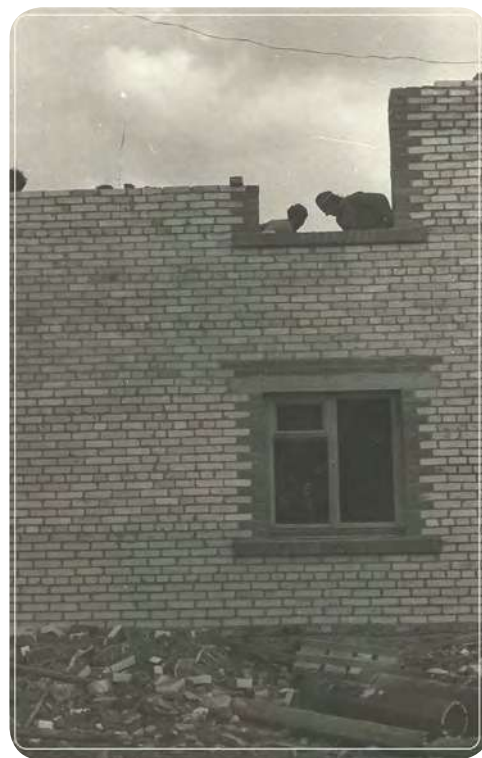
Строительный отряд ЛИТМО в Гатчинском районе на стройке восьмиквартирных домов
