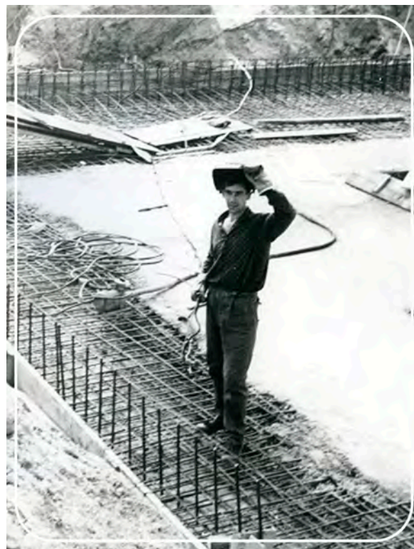
ССО «Лесное». На фотографиях: на бетонных работах при подготовке резервуара насосной станции (вверху); посвящение в бойцы ССО: боец Юрий Гатчин (внизу). 1970
