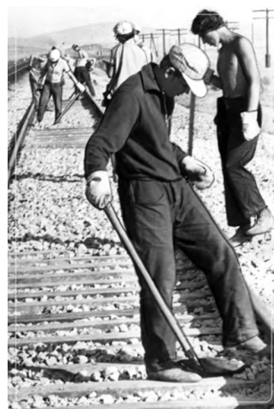
Отряд «Восток» на прокладке железной дороги. Казахстан
