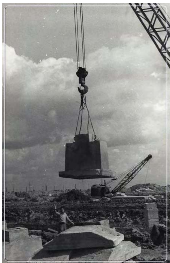
Боец строительного отряда Вячеслав Куриловский монтирует блоки фермы
