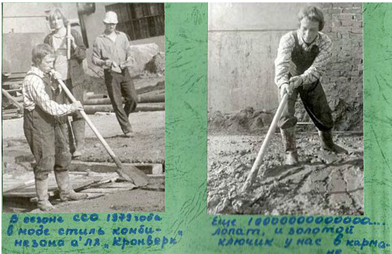
ССО «Кронверк» на строительстве фабрики нетканых материалов
