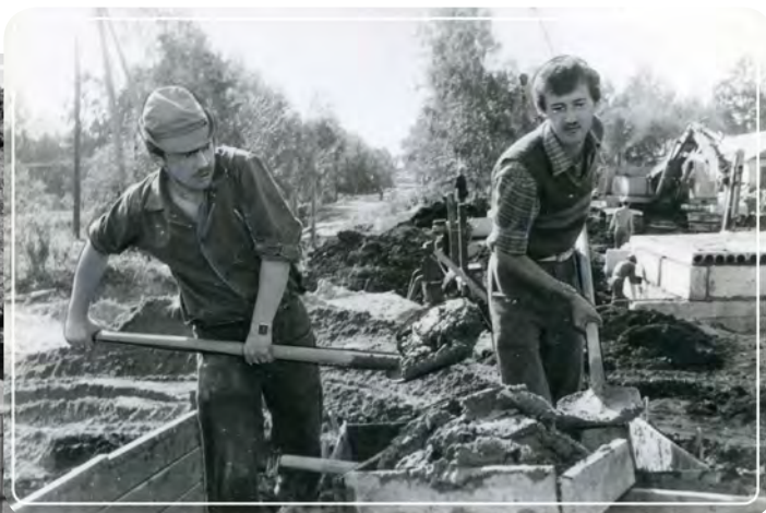
Бойцы ССО «Глория» работают на строительстве. Пос. Сиверский, Гатчинский район.
