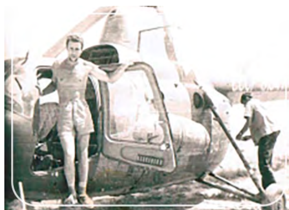
Студент А. Фельдман на строительстве газопровода Средняя Азия - Центр. Тулей. 1969
