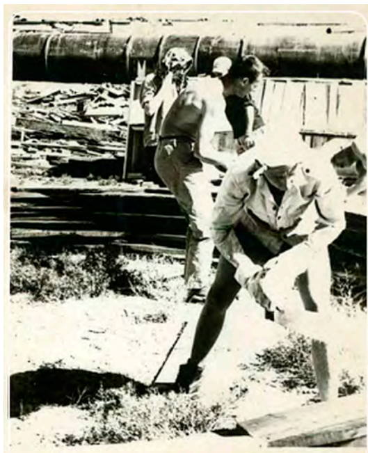
Бойцы ССО «Кульсары» Эрик Коданев и Виктор Дементьев на строительстве опалубки. Казахстан
