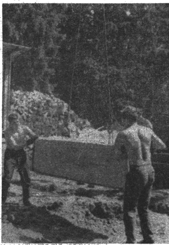
ИЗ ФОТОЛОГИИ ТРУДОВОГО СЕМЕСТРА. ОТРЯД «ГЕЛИОС». БРИГАДА БОРИСА ГУНЬКО НА СТРОИТЕЛЬСТВЕ КОТЕЛЬНОЙ. ФОТО СТУДЕНТА 428-й ГРУППЫ ВЯЧЕСЛАВА САДКО.
