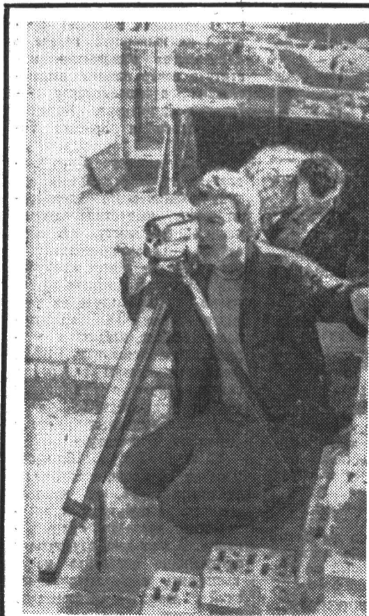
Из фотолетописи ССО-72. Бригадир отряда «НЕПОДАЮЩИЕСЯ» ЕВГЕНИЙ РОГОЗЕНКОВ НА СТРОИТЕЛЬСТВЕ ШЕСТНАДЦАТИЧЛЕНА ТИРНОГО ЖИЛОГО ДОМА В ПОСЕЛКЕ БОЛЬШОЕ ЖАБИНО.
