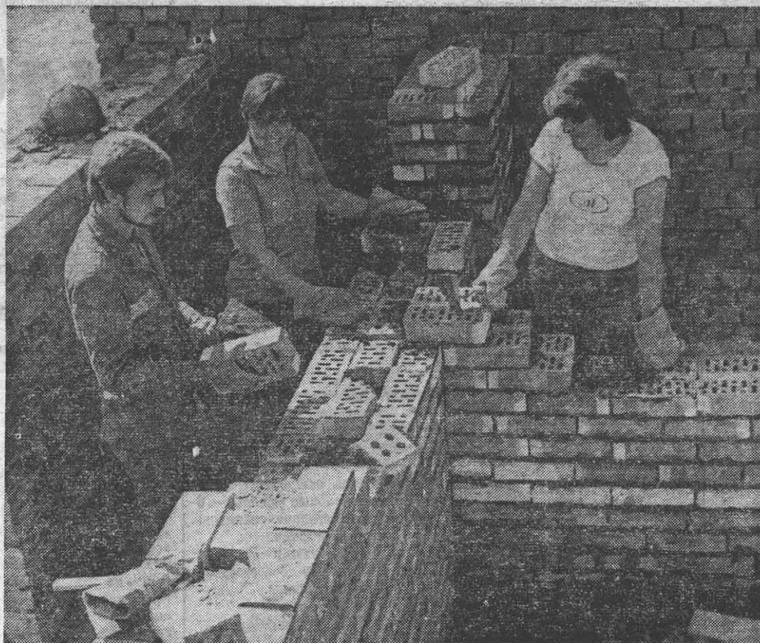
Трудовой семестр литмонавтов. Отряд «Бриз» на строительстве кинотеатра в Гатчине. Фото студента Глеба Вдовина
