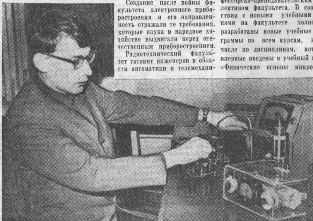
В кружках студенческого научного общества занимаются студенты не только дневного, но и вечернего отделения. На снимке студент-вечерник Юрий Романенко проводит в лаборатории кафедры радиотехники исследование лампового генератора с самовозбуждением и кварцевой стабилизацией. Фото З. САНИНОЙ
