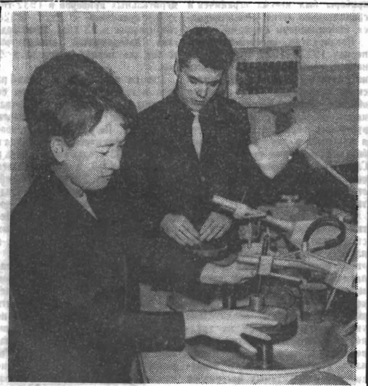
Практические занятия в лаборатории технологии оптических деталей кафедры теории оптических приборов. Студентка 435-й группы Татьяна Новикова выполняет шлифовку плоского блока, а ее товарищ по группе Владимир Фомина занят исправлением пирамидальности шлифовальных призм.
