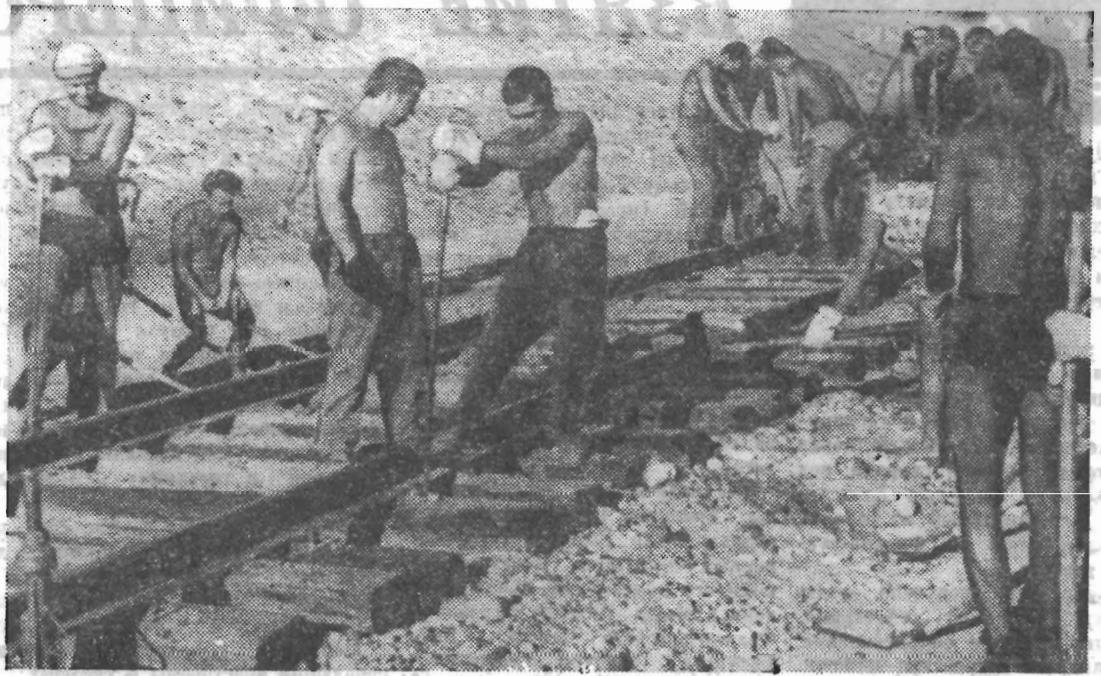
Студенты - литманавты на строительстве трассы Гурьев — Астрахань. Фото студента Михаила Венцеля
