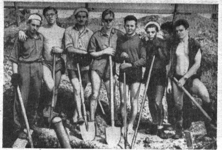
Этот снимок сделан в совхозе «Федоровский» Гатчинского района. Бригада А. Вахмистрова, работавшая на закладке фундамента, не раз проявляла исключительное упорство и трудолюбие. Служ-
