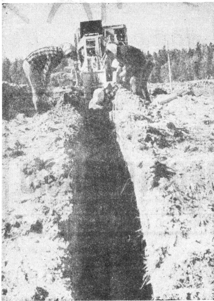
Отряд Виталия Пузанова на дренажных работах в Новоладожской ММС.
