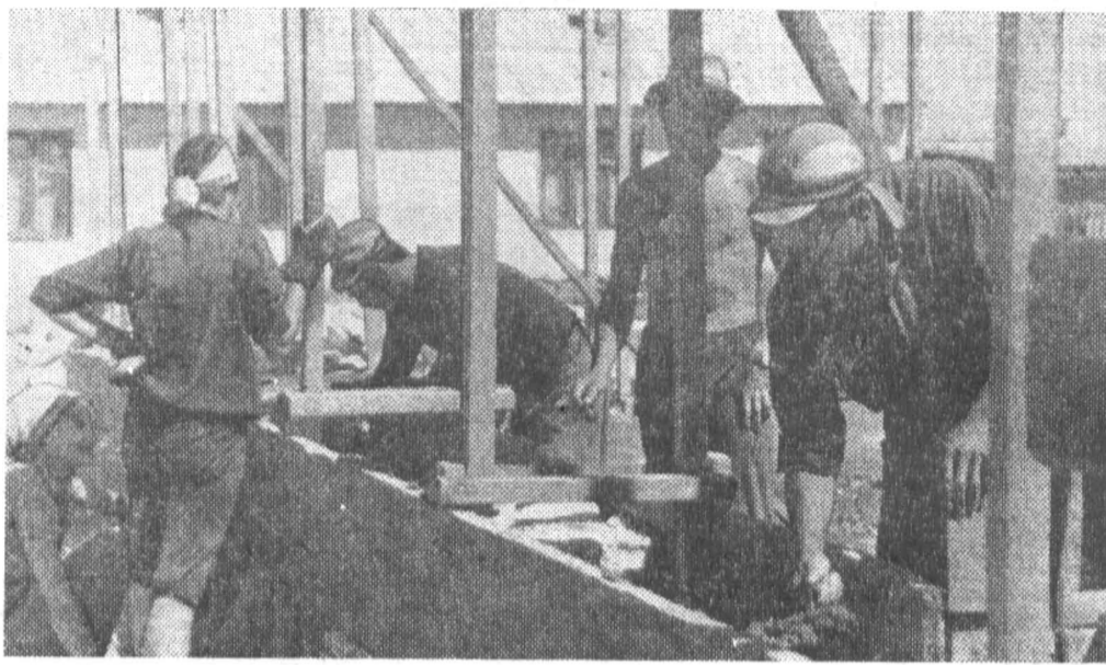
На снимке: литмонавты на стройке. Фото выпускника института Владимира Платонова.
