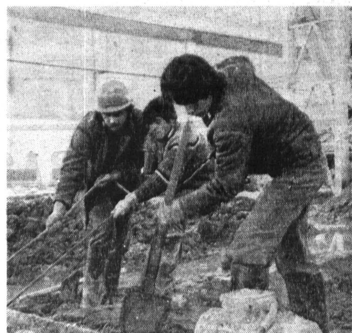
Бойцы отряда «Галера» бетонируют пол в строящемся цехе. Фото Игоря Мандзельского
