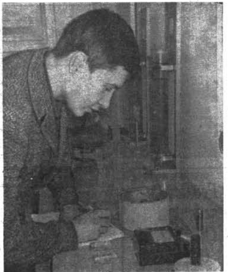
В кружке СНО при кафедре физики. Леонид Веселов определяет удельную теплоемкость методом регулярного режима.
