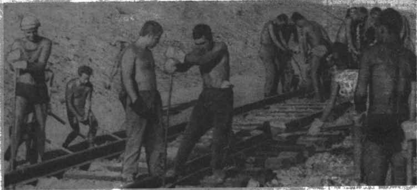
ЛИТМОНАВТЫ НА СТРОИТЕЛЬСТВЕ ЖЕЛЕЗНОДОРОЖНОЙ МАГИСТРАЛИ.
