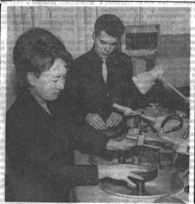
Практические занятия в лаборатории технологии оптических деталей кафедры теории оптических приборов. Студентка 435-й группы Татьяна Новикова выполняет шлифовку плоского блока, а ее товарищ по группе Владимир Фомин занят исправлением пирамидальности шлифовальных призм.
