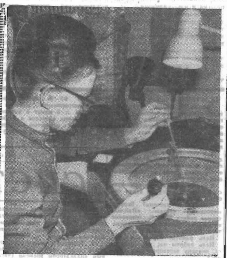
Лабораторные занятия на кафедре ТОД. Студентка 435-й группы Алесина Саблина выполняет однослойное просветление оптических деталей методом нанесения пленки из раствора кремнивого эфира.
