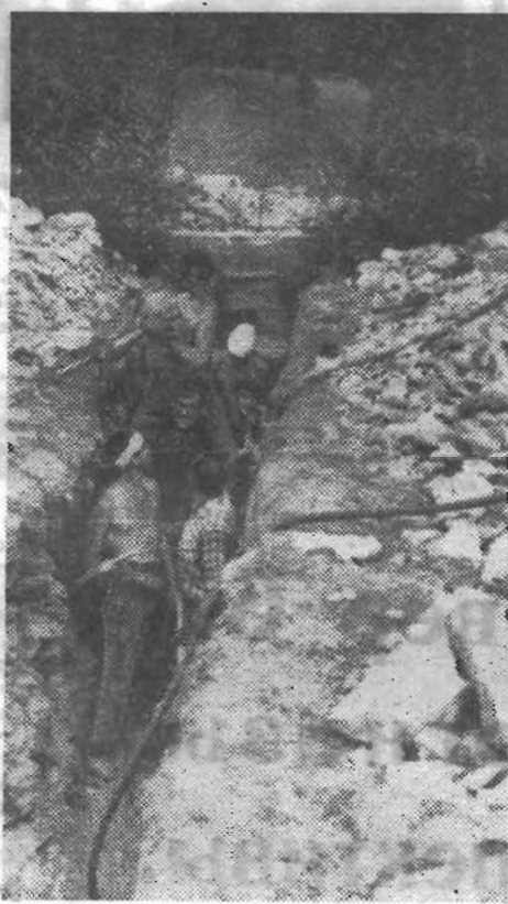
Литмонавты прокладывают траншею на стройке в чехословацком городе Тршебиче.
