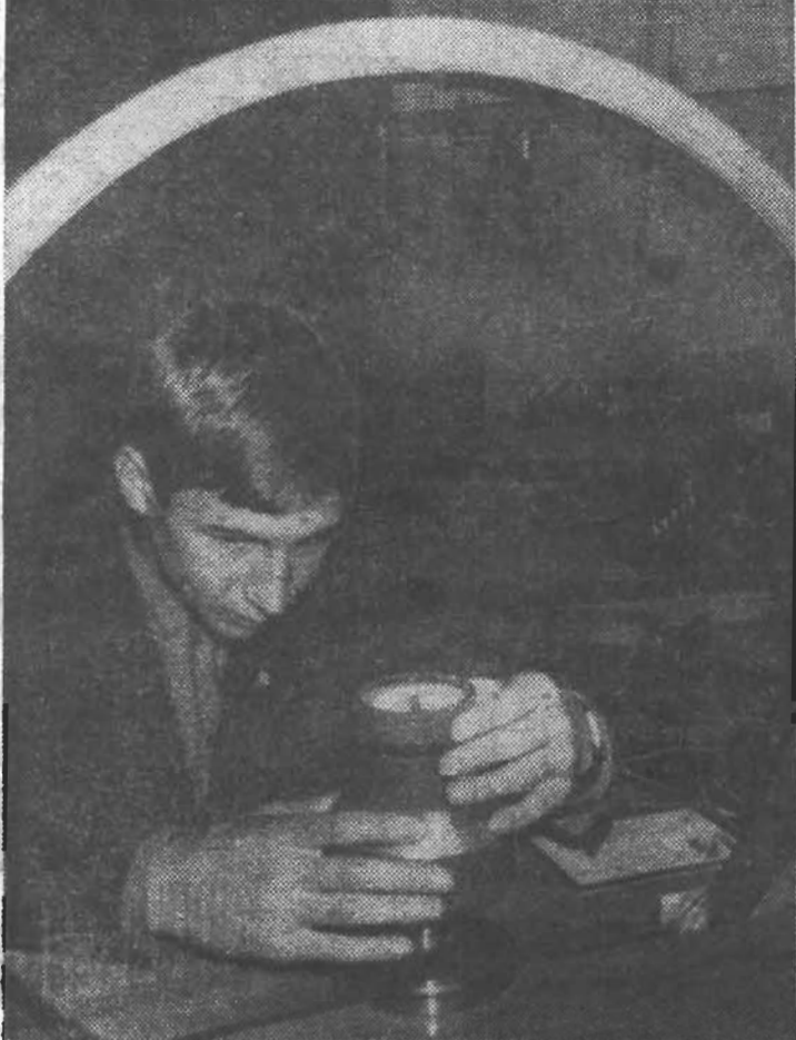
Определение постоянной тангенс-буссоли и горизонтальной составляющей поля Земли — одна из лабораторных работ, которые выполняют второкурсники на занятиях по физике. На снимке Э. Саниной студент Николай Подберезников.
