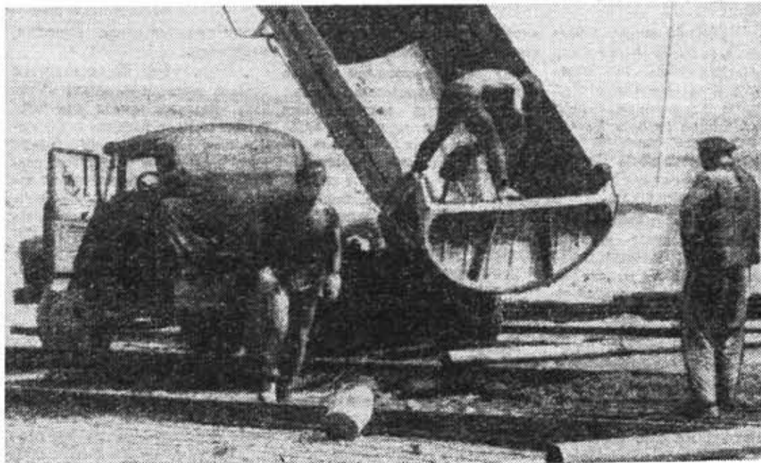
«Мубарек-69». Идет бетон! Фото студентки 447-й группы Зои Правдивец
