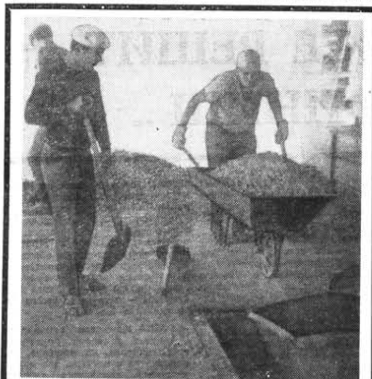
Фотолетопись трудового семестра. Бетонные работы в Мубареке. Фото студента 671-й группы Владимира Игнатова
