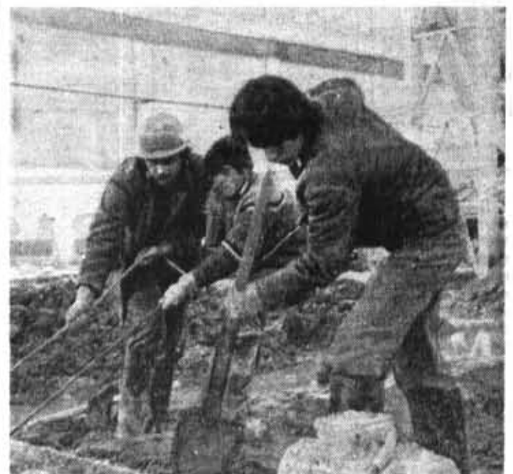
Бойцы отряда «Галера» бетоннируют пол в строящемся цехе. Фото Игоря Мандзельского
