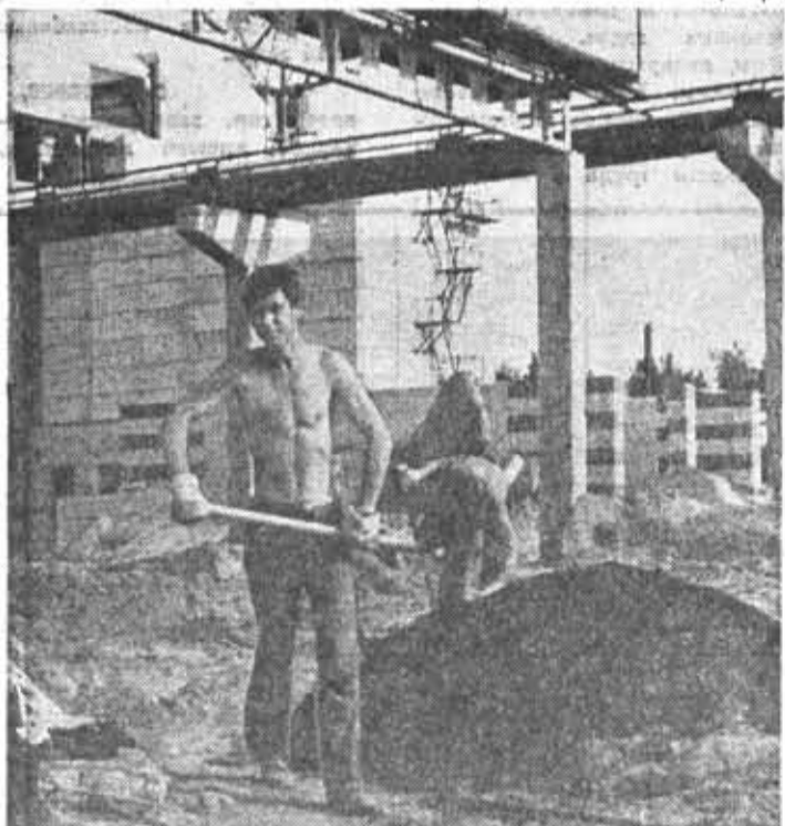
На стройке всему находят применение: и ковшу экскаватора, и простой лопате.
