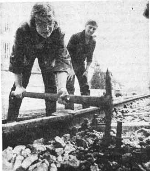
Оксана Саламатина и Виктор Тихонов прокладывают трамвайную линию в Йене.
